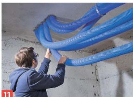
9 Die Flexrohre für Zu- und Abluft am besten möglichst gebündelt in Abkastungen an der Wand oder unter der Decke verlegen.
