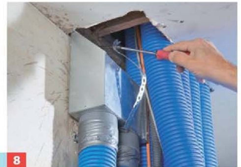
6 Für den Anschluss der Flexrohre an den Eckübergang klemmen Sie einen Dichtring für Flexrohr DN 75 über das Rohrende.
