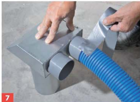
5 Die Verbindung von Flexrohren und Zu- und Abluftventilen stellen Eckübergänge her. Verschlusskappen bei Bedarf entfernen.
