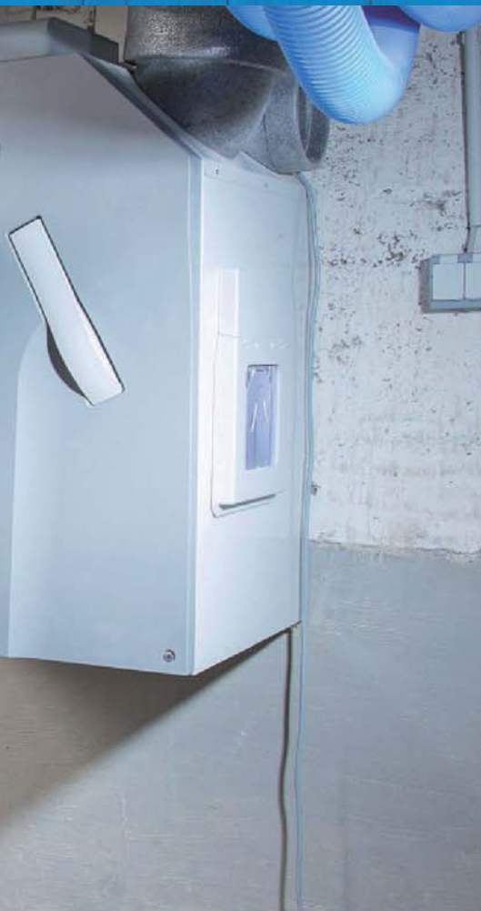
5 Die Verbindung von Flexrohren und Zu- und Abluftventilen stellen Eckübergänge her. Verschlusskappen bei Bedarf entfernen.
