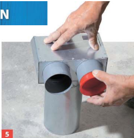
5 Die Verbindung von Flexrohren und Zu- und Abluftventilen stellen Eckübergänge her. Verschlusskappen bei Bedarf entfernen.
