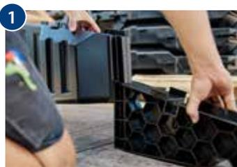
1 Tank-Modul mit Adaptern (links/rechts) verbinden.
