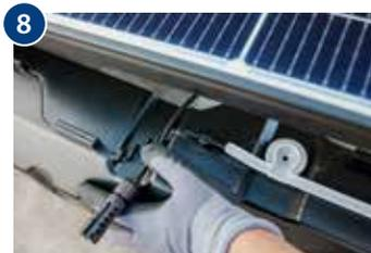
8 Kabel des PV-Moduls durch die Kabelführung legen und einklicken.
