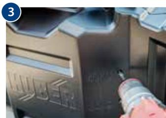
3 Überlaufbohrung setzen (gemäß Ballastierungsvorgabe\*).
